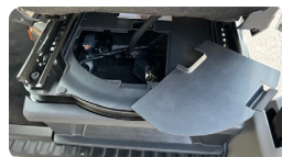
Batteria della zona living
